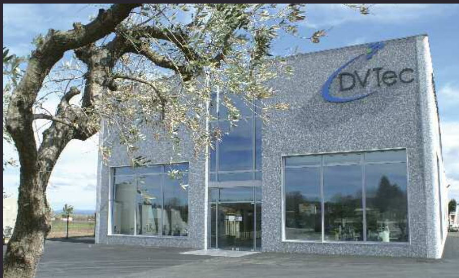
Le bâtiment DVTec inauguré en mai 2013.
